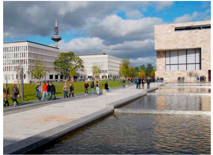
Campus Westend der Goethe-Universität: Als lokal und regional verankerte Hochschule soll sie auch internationale Strahlkraft entfalten.
